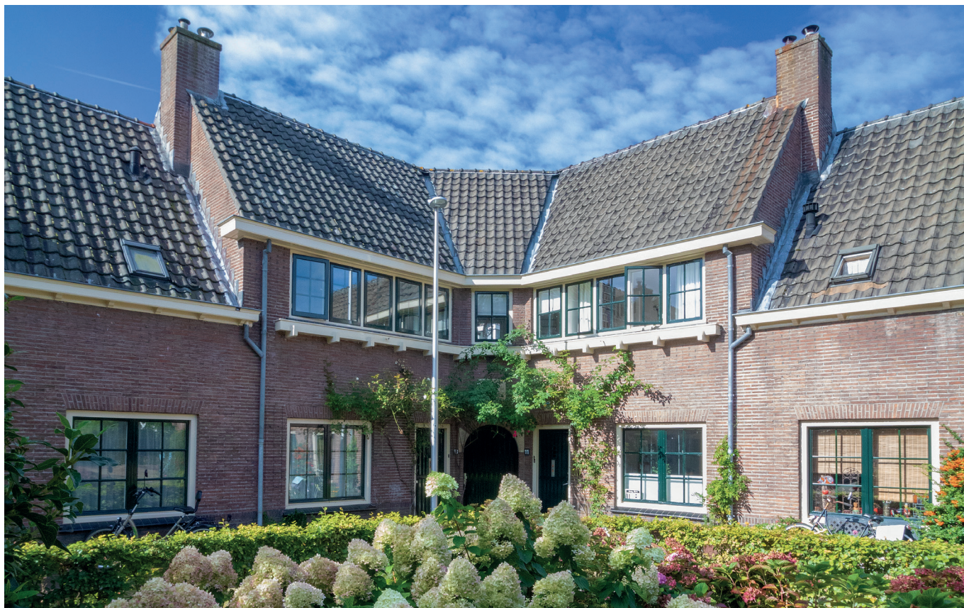
'Hoofdgebouw' van de woningen aan de Wulpstraat, met poortje en gedenksteen; onder ook een aantal van de woningen.
